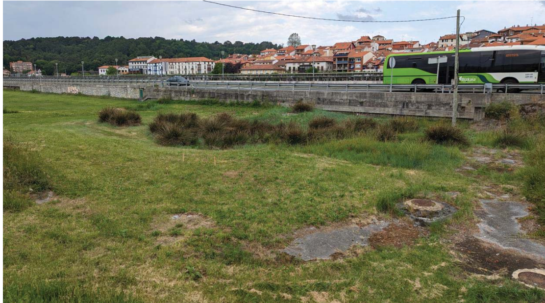
Imagen 3. Aspecto general de la zona en la que se encuentran los juncos. Se aprecian zonas de hormigón y varias de las arquetas presentes
